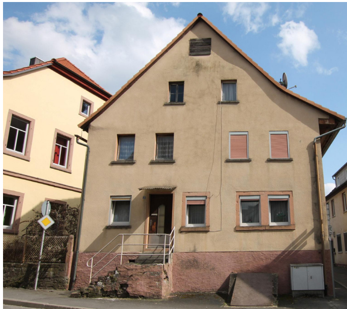
Bestandsfoto Wohngebäude Hauptstraße 2/ Schulgasse 1 Quelle: Haines-Leger
